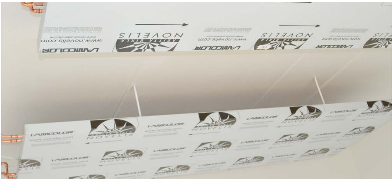
Frenger HKE säteilijä toimitetaan muovisuojalla mikä poistetaan vasta ennen käyttöönottoa
